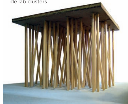
2/ Model funderingspalen onder een van de lab clusters
